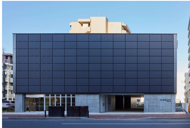
エネフィス北海道 壁面もソーラーパネルの寒冷地『ZEB』
