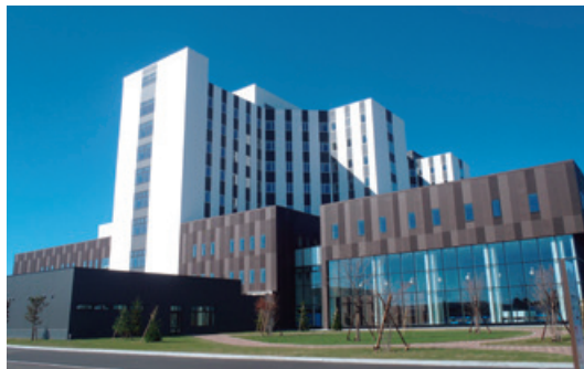
帯広厚生病院移転整備 水道衛生工事
