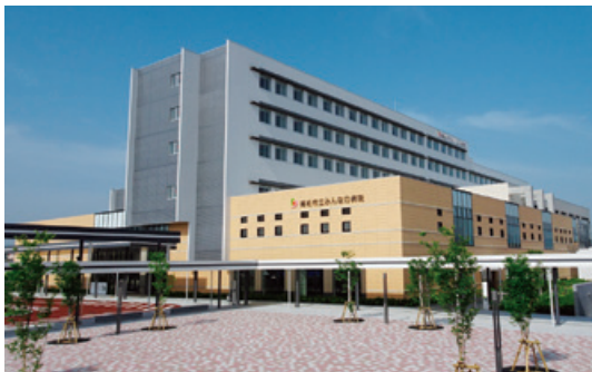
高松市立みんなの病院 空調・水道衛生工事
