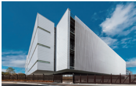
netXDC三田第2センター 空調・水道衛生工事
