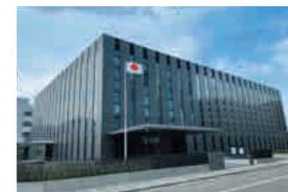
日本銀行金沢支店 【空調・給排水衛生設備工事】
