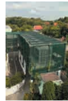
リゾートワールド センターサ 第2地冷設備機械室 (シンガポール) 【電気・空調・給排水 衛生設備工事】
