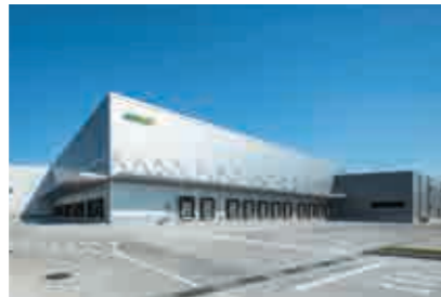
イオンネクスト株式会社誉田CFC(千葉県) 【空調・給排水衛生設備工事】
