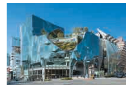
東急プラザ原宿「ハラカド」(東京都) 【空調・給排水衛生設備工事】 撮影: (株)エスエス 中島真吾
