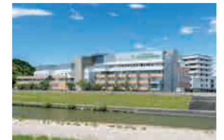
岐阜県立多治見病院 【空調設備工事】
