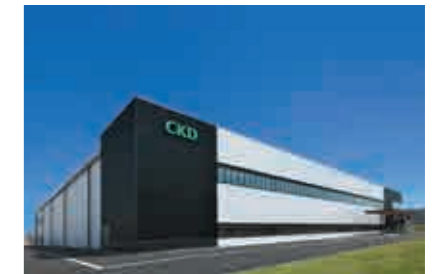
CKD株式会社北陸工場(石川県) 【電気設備工事】
