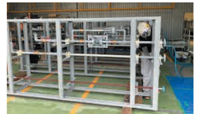
配管ユニット検査状況
