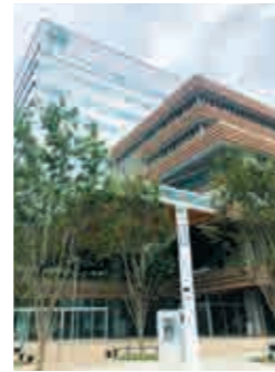
千葉市役所 新庁舎 【空調設備工事】
