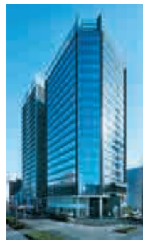
アーバンネット名古屋 ネクスタビル 【空調・給排水衛生設備工事】 ©Forward Stroke inc.
