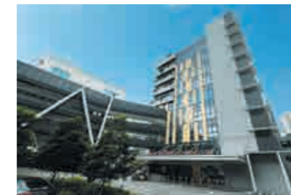
マウントアルベニア病院産婦人科棟(シンガポール) 【空調・電気設備工事】
