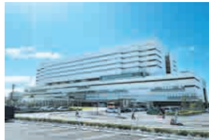
トヨタ記念病院(愛知県) 【電気設備工事】
