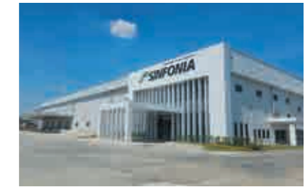
タイランド シンフォニアPH-3 工場 【空調、衛生、電気設備工事】
