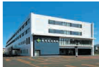
静和記念病院(北海道) 【空調・給排水衛生設備工事】
