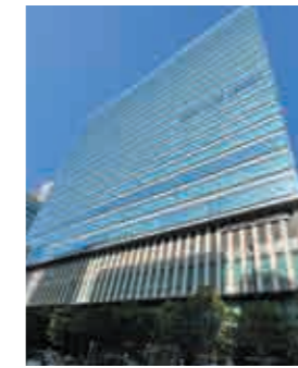
文京ガーデン ゲートタワー およびセンター テラス (東京都) 【空調・給排水 衛生設備工事】
