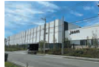
JASM FAB棟(熊本県) 【空調設備工事】
