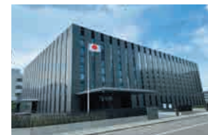
日本銀行金沢支店 【空調・給排水衛生設備工事】
