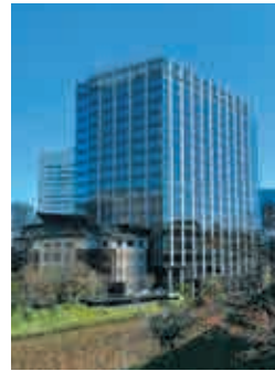
九段会館テラス (東京都) 【空調設備工事】
