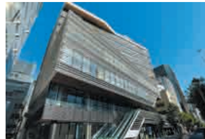
GRANBELL SQUARE(東京都) 【電気・空調・給排水衛生設備工事】
