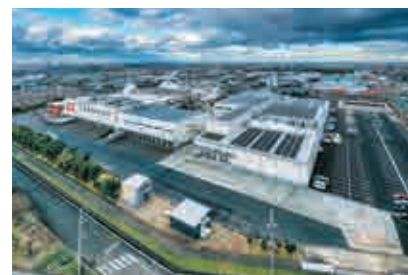
一正蒲鉾株式会社本社第二工場(新潟県) 【空調・給排水衛生設備工事】
