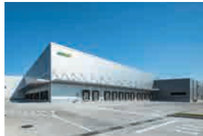
イオンネクスト株式会社誉田CFC(千葉県) 【空調・給排水衛生設備工事】
