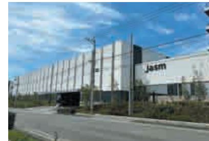
JASM FAB棟(熊本県) 【空調設備工事】
