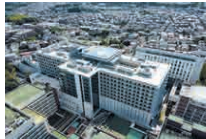
聖マリアンナ医科大学入院棟(神奈川県) 【空調設備工事】
