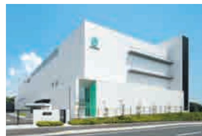
ビオフェルミン製薬株式会社神戸第二工場 【空調・給排水衛生設備工事】
