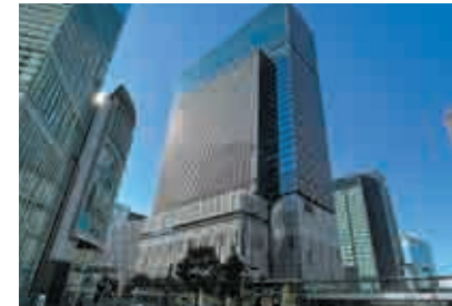
JPタワー大阪 【空調・給排水衛生設備工事】
