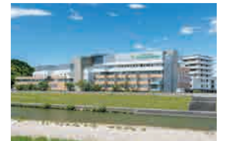
岐阜県立多治見病院 【空調設備工事】
