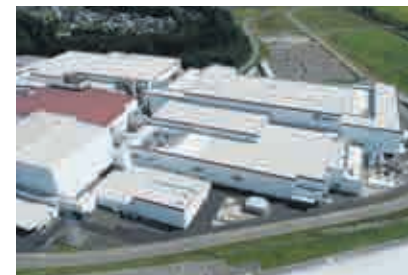
ニプロ株式会社大館工場第7工場(秋田県) 【空調・給排水衛生設備工事】
