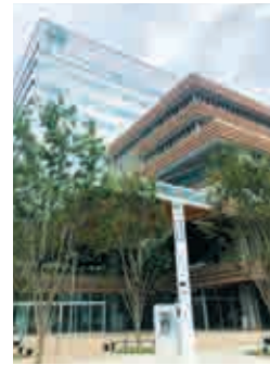
千葉市役所 新庁舎 【空調設備工事】
