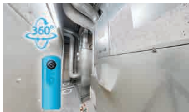
360度カメラによる現地の3次元記録
