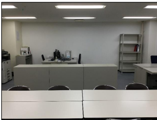
作業所事務所の改修前
