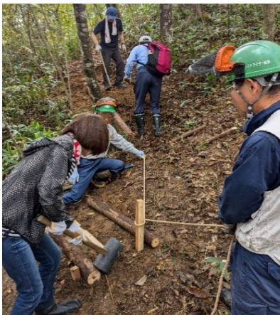
遊歩道となる階段を設置する様子
